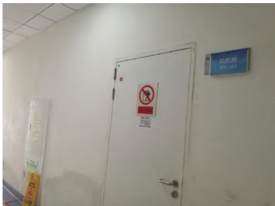
楼下空调机房
